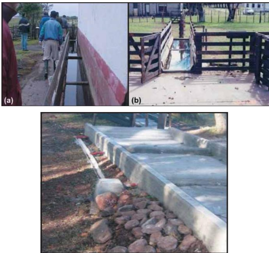
Figura N° 103: Pediluvios de forma rectangular (a y b). Piso, zócalo, pendiente y desagüe del pediluvio
